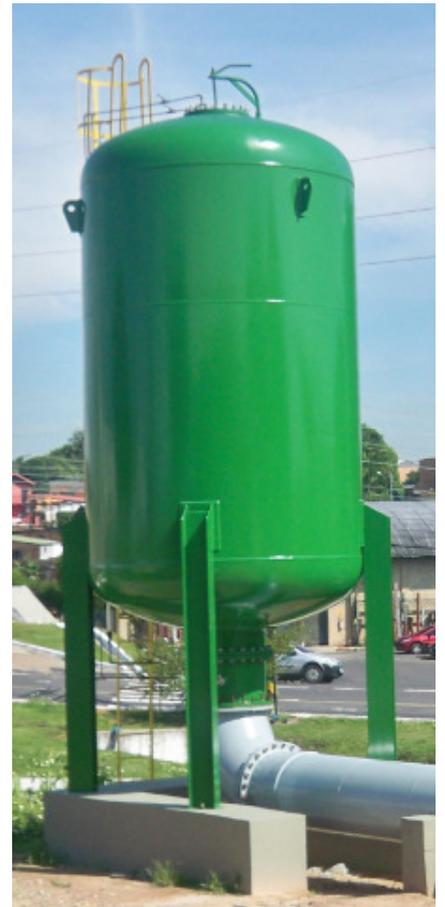
Sección III, para vasos de presión es usado para el dimensionamiento, fabricación e inspección de todos los HYDRAMER®. Para garantía de la calidad total de los suministros, todos los HYDRAMER® son sometidos a ensayo hidrostático de presión de acuerdo a la norma o 1,3 veces la presión nominal.
